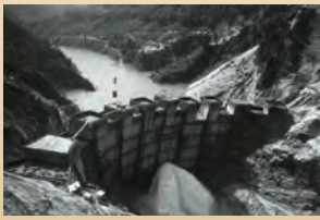
建設中黒部ダム一部発電開始 （関西電力株式会社提供）
